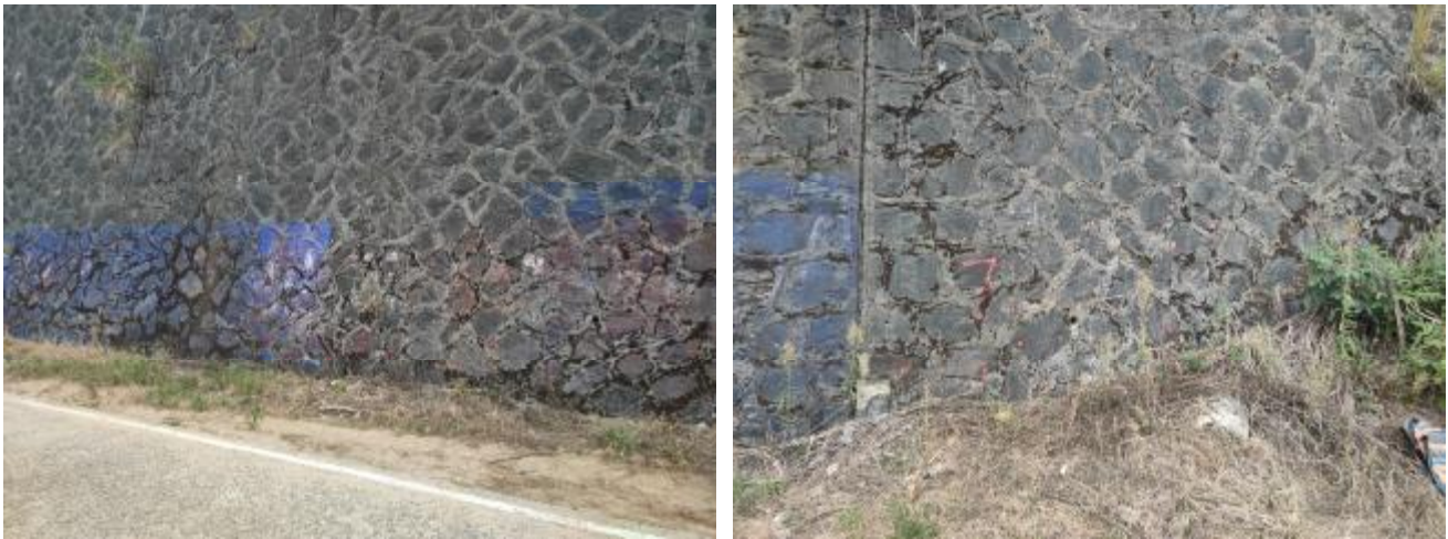
图 4、5.墙面起皮松动
