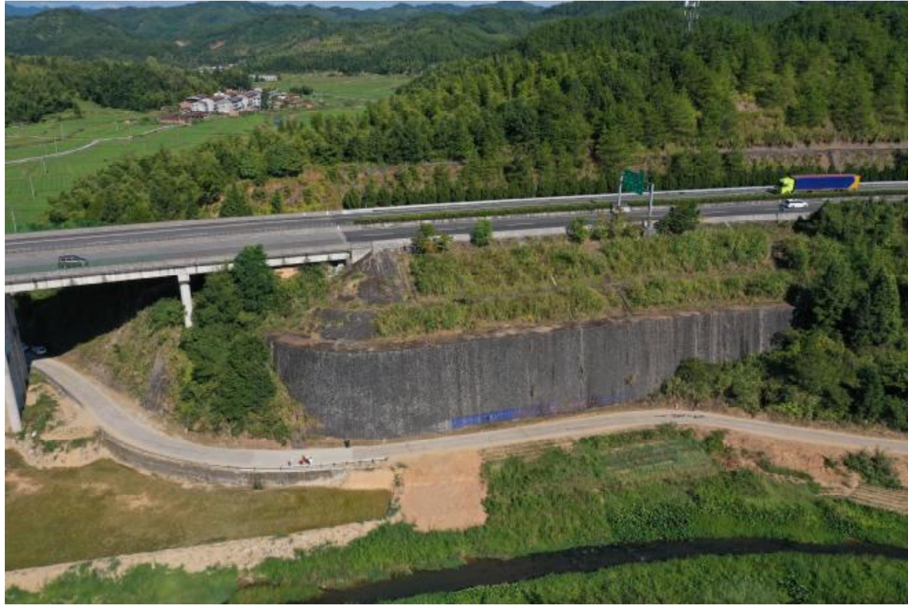
图 1.挡墙段航拍图
