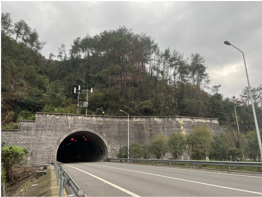
图 1 性天峰隧道洞门墙
