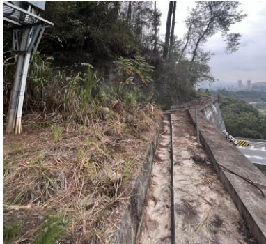
图 4 性天峰隧道洞门墙顶平台
