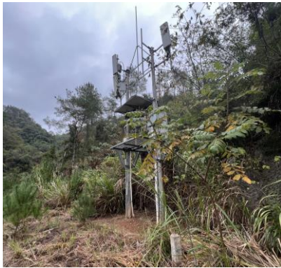
图 2 性天峰隧道洞门墙顶信号塔
