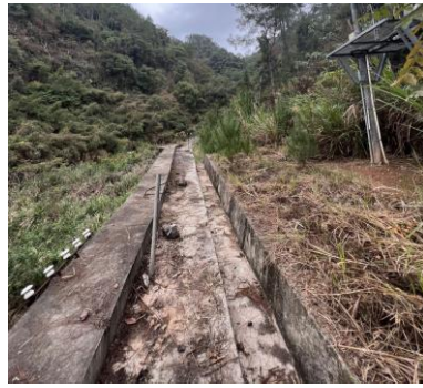
图 5 性天峰隧道洞门墙顶平台
