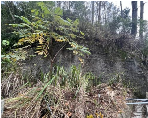
图 3 性天峰隧道洞门墙顶喷砼防护
