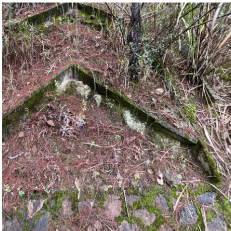
图 5 第六阶拱形骨架开裂
