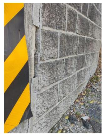
图 2. 墙顶及排水沟开裂
