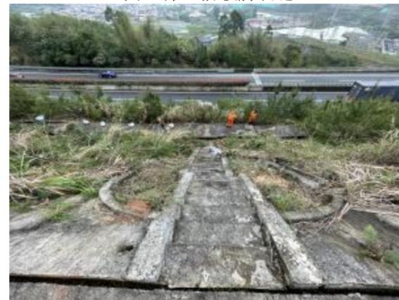
图 3 第二阶坡面开裂、下错
