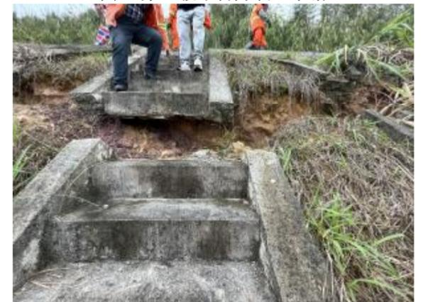
图 4 第二阶流水槽开裂、下错
