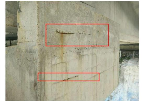
图 3-12: 坂面大桥(下行)10 盖梁: 距小桩号面 0.2m 起, 距上缘 0.3m 处, 右侧挡块露筋; 数量: 2 处, 长度: 0.25m, 宽度: 0.02m。
