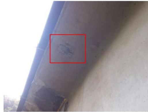
图 3-6: 沙县沙溪大桥(上行)7-5T 梁: 距 7 号墩 0.5m 处, 左翼缘板破损露筋; 数量: 1 处, 长度: 0.2m, 宽度: 0.15m。
