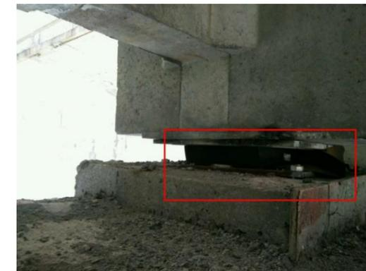
图 3-13: 坂面大桥(上行)8-7-5 支座: 大桩号面纵向剪切; 数量: 1 个, 角度: 15°。
