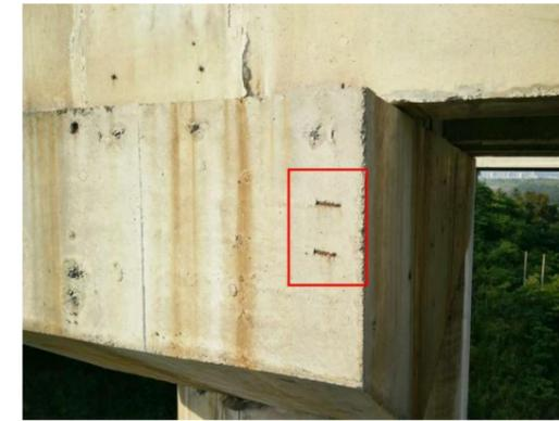
图 3-11: 沙县沙溪大桥(下行)6 盖梁: 距小桩号面 0.2m 处, 距上缘 0.3m 处, 左侧挡块露筋; 数量: 2 处, 长度: 0.1m, 宽度: 0.02m。
