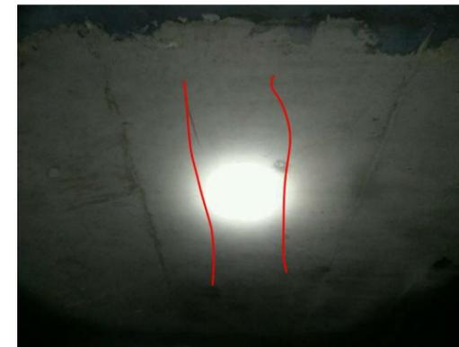
图 3-1：沙县沙溪大桥（下行）4A-12 箱梁：距右侧 1.5m 起，梁顶纵向裂缝；数量：2 条，长度：1m，宽度：0.14mm。
