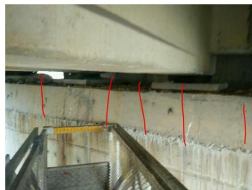
图 3-9: 沙县沙溪大桥(下行)5 盖梁: 距左侧 1.5m 起, 距上缘 0m 起, 大桩号面竖向裂缝; 数量: 6 条, 长度: 0.5m, 宽度: 0.15mm。
