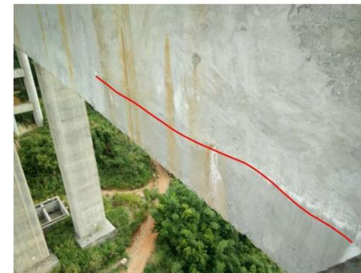
图 3-3：坂面大桥（上行）5-5-4 箱梁：距下缘 0.3m 处，右腹板纵向裂缝；数量：1 条，长度：2m，宽度：0.18mm。
