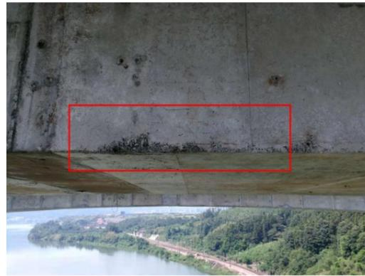
图 3-5: 沙县沙溪大桥(下行)3B-15 箱梁: 距下缘 0m 处, 左腹板蜂窝、麻面; 数量: 1 处, 长度: 0.3m, 宽度: 0.1m。
