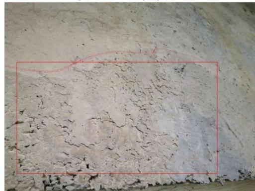
图 3-7: 坂面大桥(上行)5-5-10 箱梁: 右腹板蜂窝、麻面; 数量: 1 处, 长度: 0.38m, 宽度: 0.28m。
