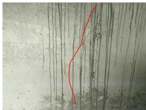
图 3-10: 玉园大桥左幅 6 盖梁: 距左侧 2m 处, 距上缘 0.2m 起, 小桩号面竖向裂缝; 数量: 1 条, 长度: 1m, 宽度: 0.11mm。
