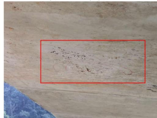
图 3-8: 玉园大桥(下行)4-3-5 箱梁: 距左侧 0m 处, 梁底蜂窝、麻面; 数量: 1 处, 长度: 0.48m, 宽度: 0.14m。
