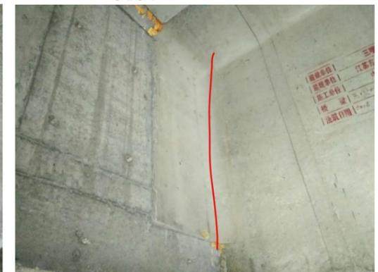
图 3-4：玉园大桥（下行）8-1-1 横隔板：距左侧 0m 处，大桩号面竖向裂缝；数量：1 条，长度：1.5m，宽度：0.12mm。
