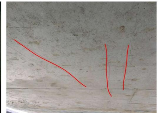
图 3-2：沙县沙溪大桥（上行）3DIB 箱梁：距 2 号墩 30m 处，距左侧 2m 处，梁底纵向裂缝；数量：3 条，长度：1m，宽度：0.14mm。
