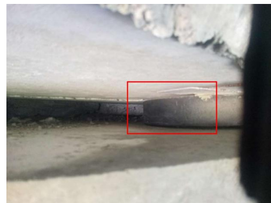
图 3-15: 湖柄分离式桥（下行）ZZ-4-4-1 支座：大桩号面脱空；数量：1 个，百分比：35%。
