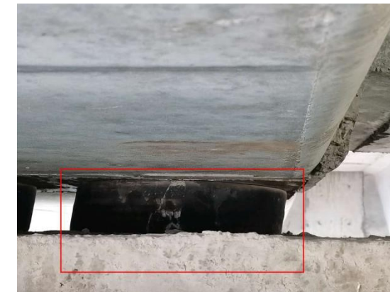
图 3-17: 黄石高架桥（上行）ZZ-60-60-9 支座：横向剪切；数量：1 个，角度：15°。
